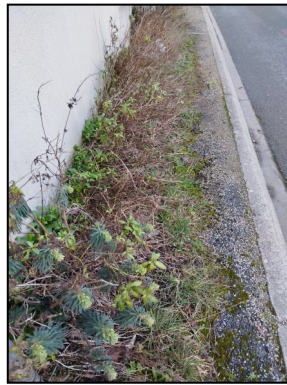
Plantes envahissantes gênant la circulation des piétons
